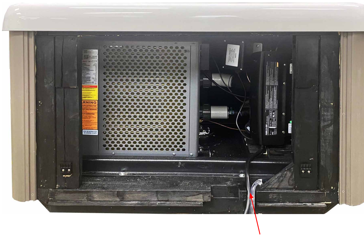
voedingskabel & afvoerbuys in uitsnijding
